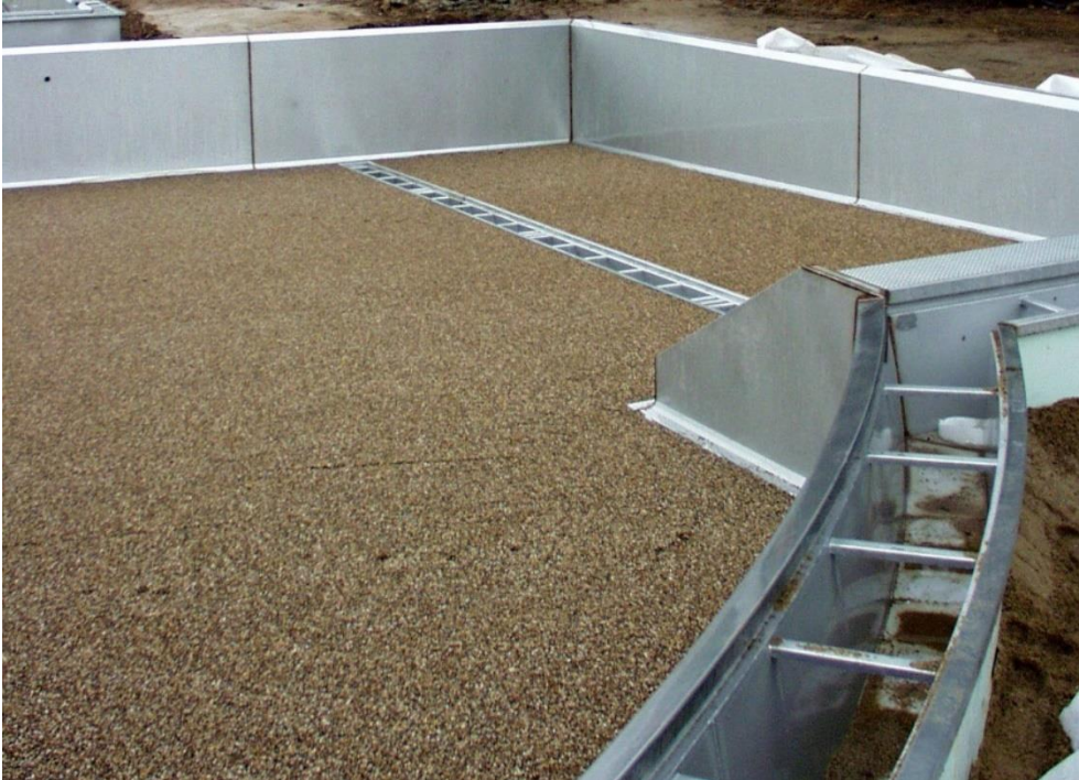
NSB vor dem Einbringen der Bodenbleche
