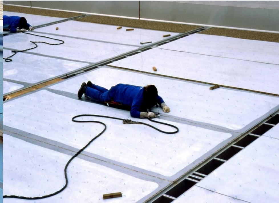
Installation Bodenkanäle (Einströmsystem) Einschweißen der Bodenbleche
