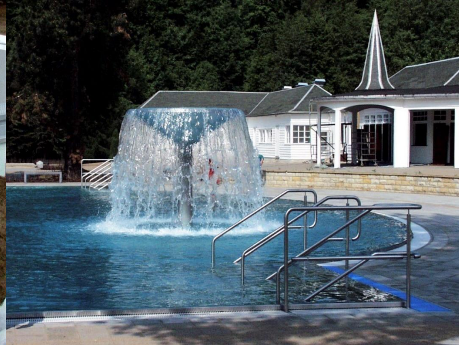
NSB Einbau Wasserattraktionen
